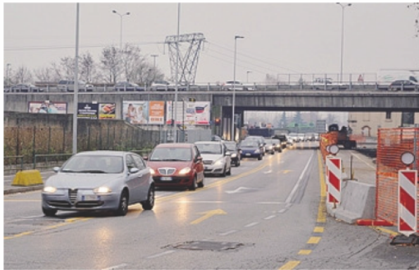
I lavori lungo via Zanica
